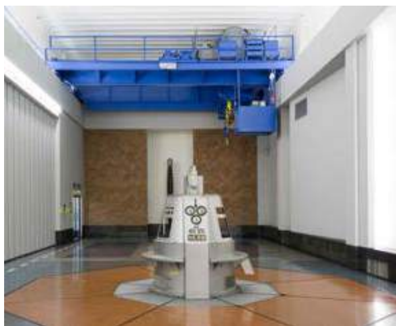
Nes kraftstasjon i Hallingdal (Foto: Hafslund Eco)
