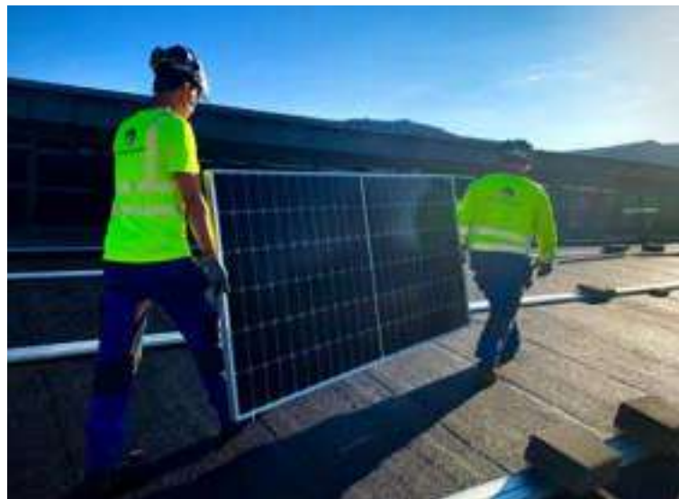
Montering av solcelleanlegg. (Foto: Solcellespesialisten)
