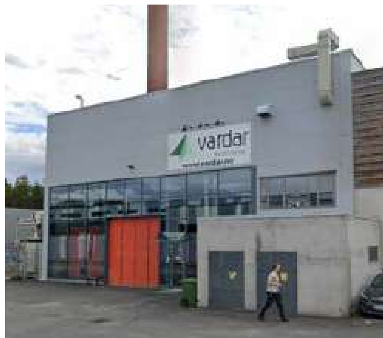
Varmesentralen på Hønefoss. (Foto: Vardar varme)
