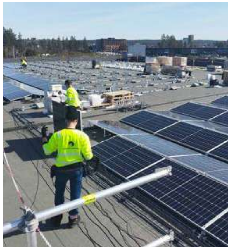
Montering av solcelleanlegg. (Foto: Solcellespesialisten)
