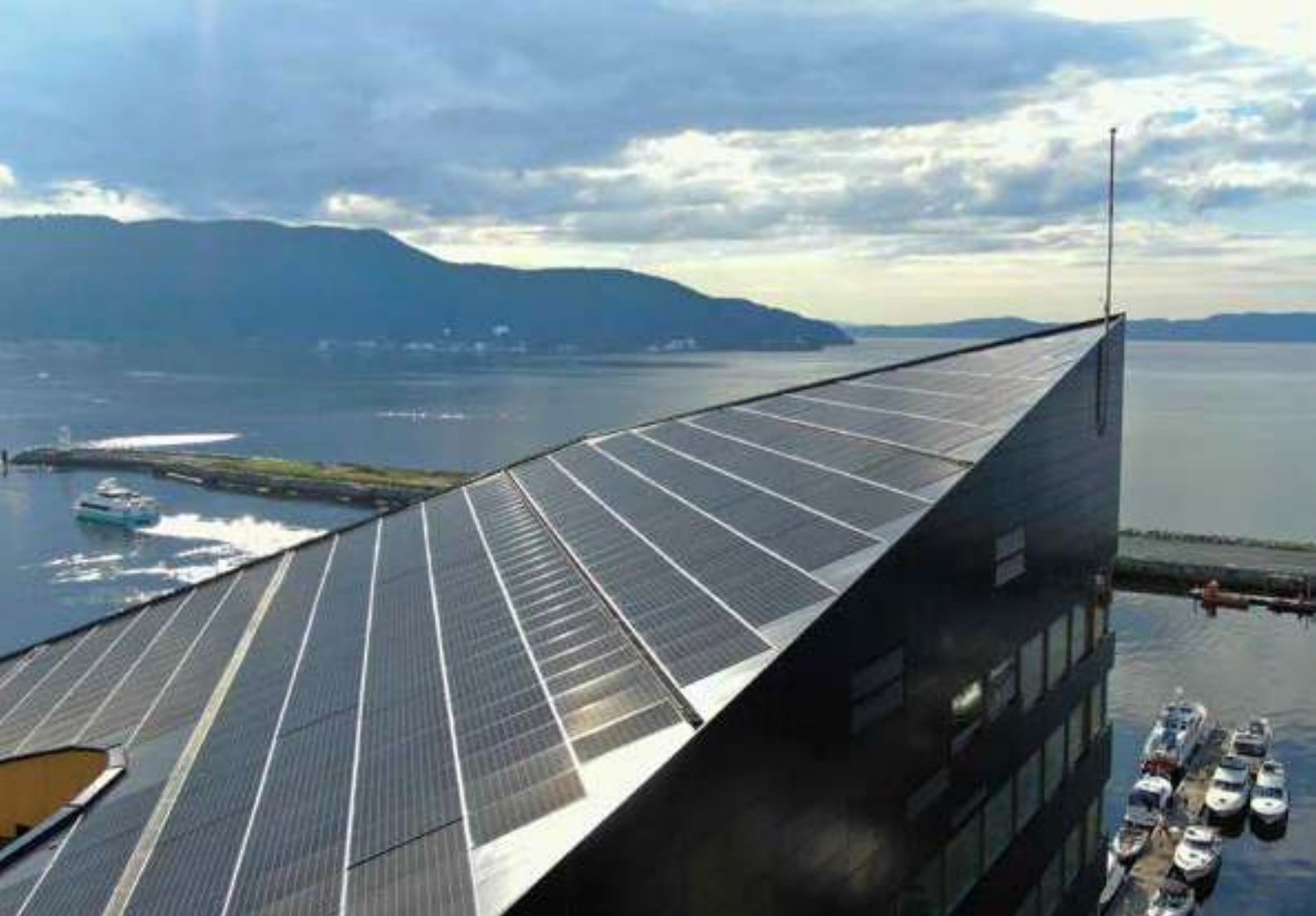
Powerhouse Brattørkaia i Trondheim har integrerte solcellepaneler på tak og fasade. (Foto: Solcellespesialisten)
